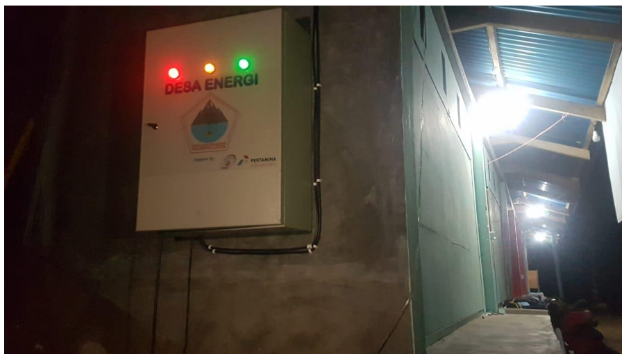
Gambar 3. Unit PLTS off-grid rakitan pengabdian menerangi pemukiman Desa Pulisan. Sumber: Dokumentasi pengabdian.
